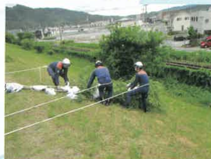
急流部の流水を緩和し堤防の洗堀を防ぐための「木流し工」
