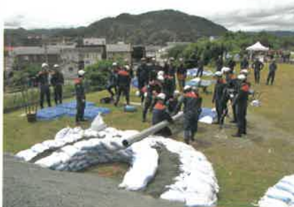
堤防裏側等に漏水があり堤防の法崩れを防ぐための「月の輪工」
