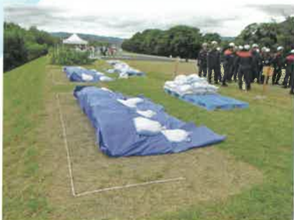
堤防越水防止のための「改良積み土のうエⅡ」
