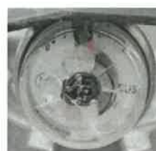
× 指示圧力計の損傷
