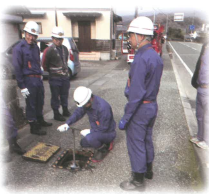
消火栓点検の様子
